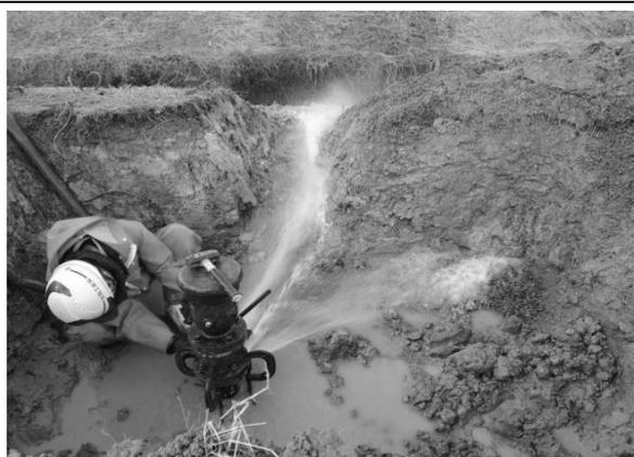
▲水道本管の空気弁からの漏水
