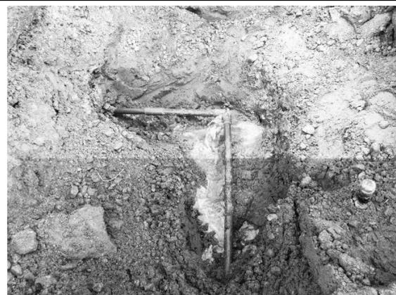
▲水道給水管からの漏水
