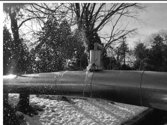
▲水管橋の空気弁からの漏水
