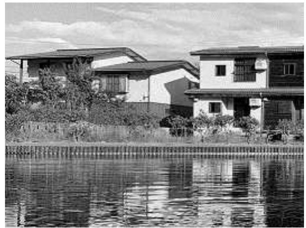
内堀護岸更新（高田城址公園）
