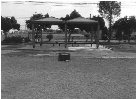
スポーツ公園パーゴラ更新工事
