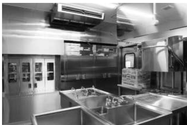
黒田小学校給食室改修状況（洗浄室）
