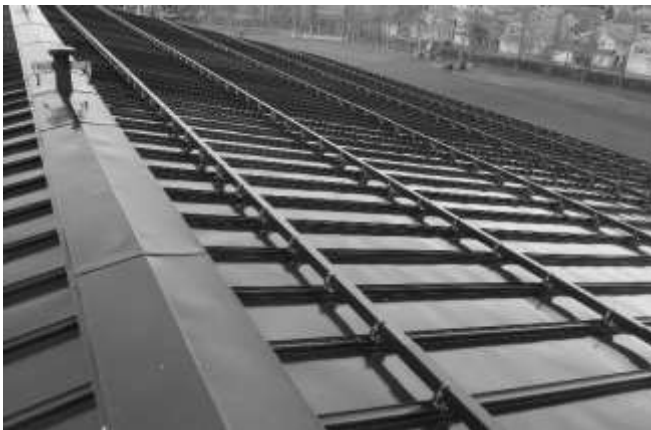
春日中学校校舎屋根防水改修状況
