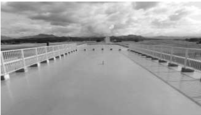
大瀧小学校防水改修状況
