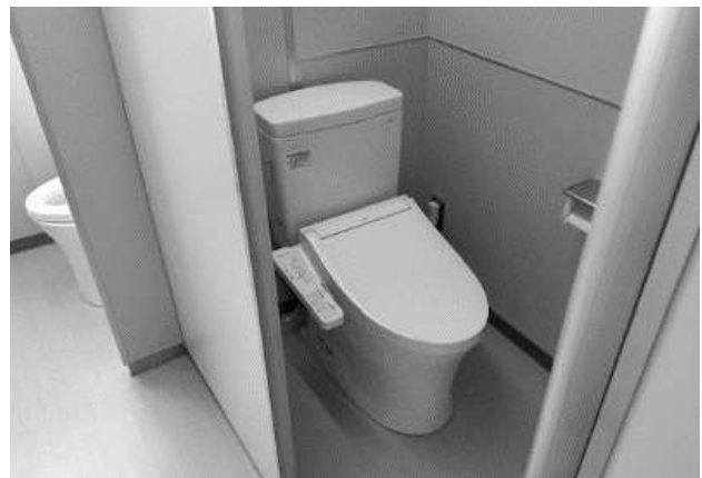
直江津中学校校舎トイレ改修状況
