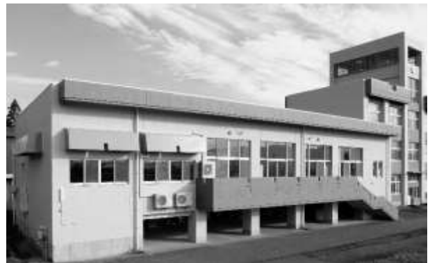
黒田小学校外壁改修状況
