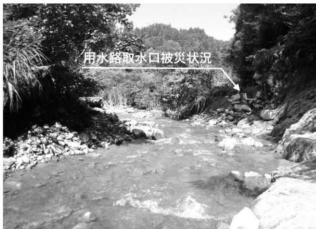
棚広下江用水路（取水口）
