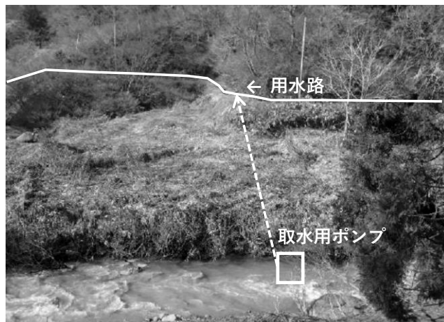
棚広下江用水路（取水用ポンプ設置）
