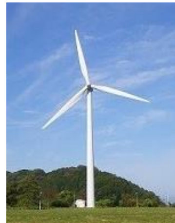
風力発電施設3号機
