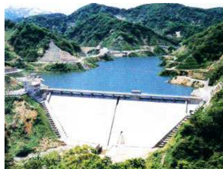
正善寺ダム（上正善寺地内）
