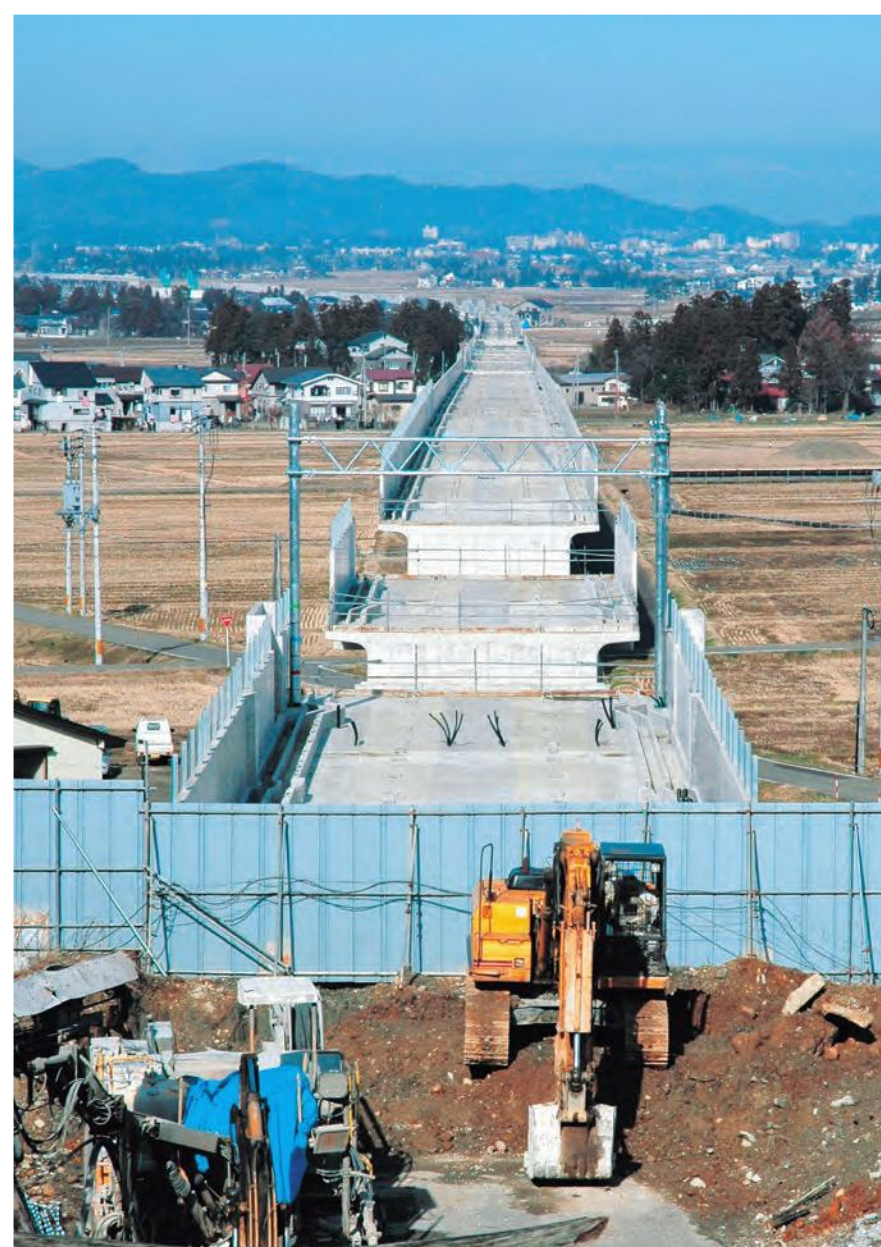
北陸新幹線 建設の様子(2003・平成15年)
