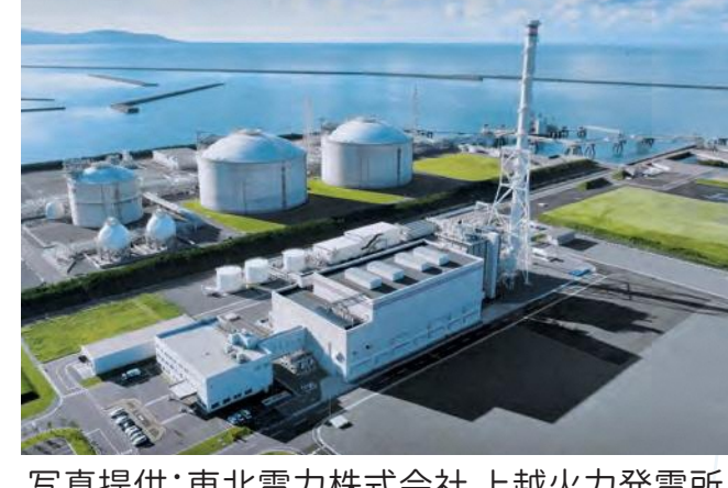
写真提供:東北電力株式会社 上越火力発電所
