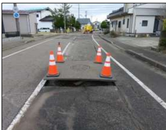
液状化により浮上したマンホールの状況 (五智 3 丁目地内)
