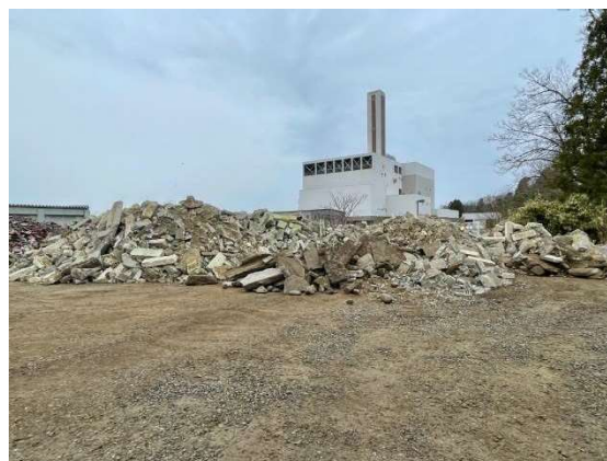
仮置場開設後（コンクリートがら）
