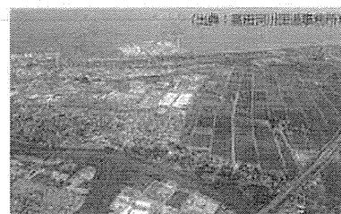
保倉川放水路予定地周辺
