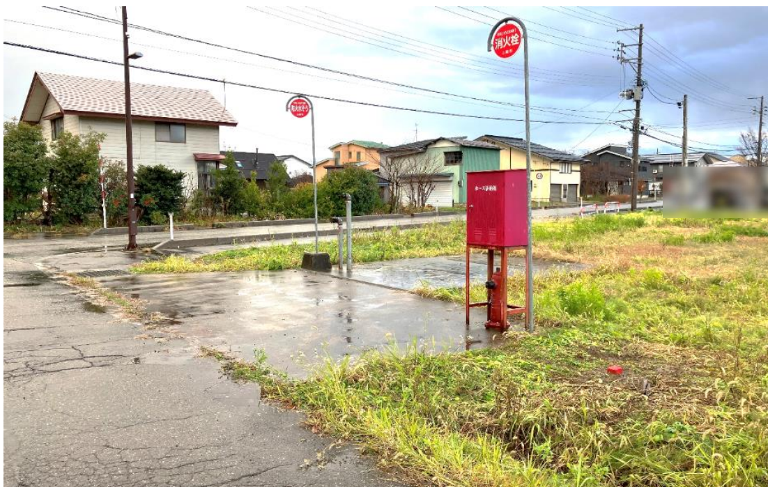
▲物件隣接防火水槽(北東角、売払地対象外)
