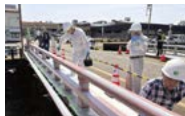
歓喜橋の塗装作業の様子
