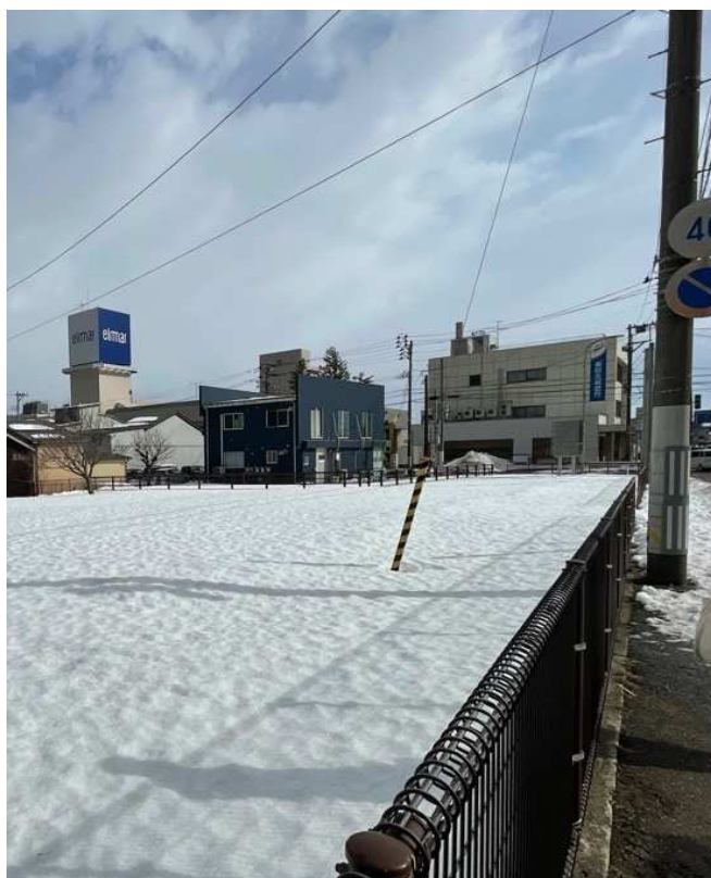
【敷地内電柱支線】
