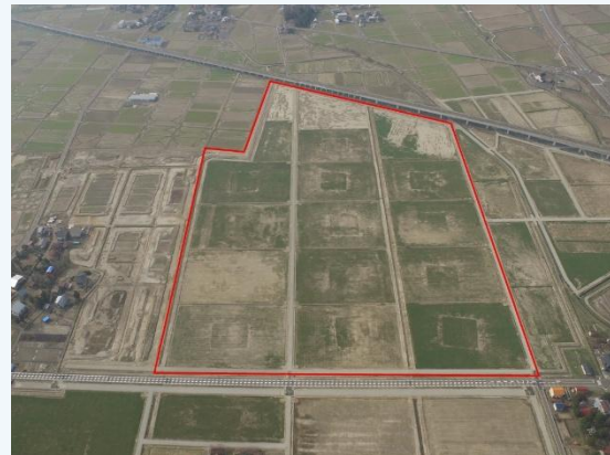
▲県営経営体育成基盤整備事業(木島地区 着手後)
