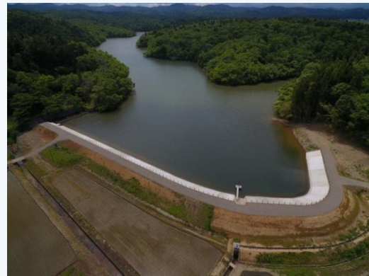
▲県営防災重点農業用ため池緊急整備事業 (大久保地区 完了後)
