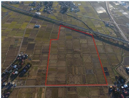
▲県営経営体育成基盤整備事業(木島地区 着手前)
