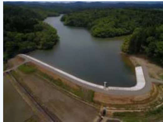
▲県営防災重点農業用ため池緊急整備事業 (大久保地区 完了後)
