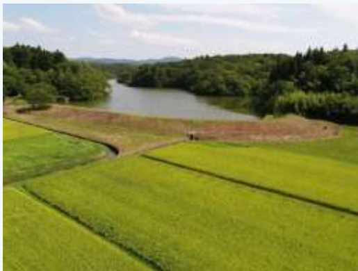
▲県営防災重点農業用ため池緊急整備事業 (大久保地区 着手前)
